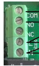
TBV elektrische verwarming
